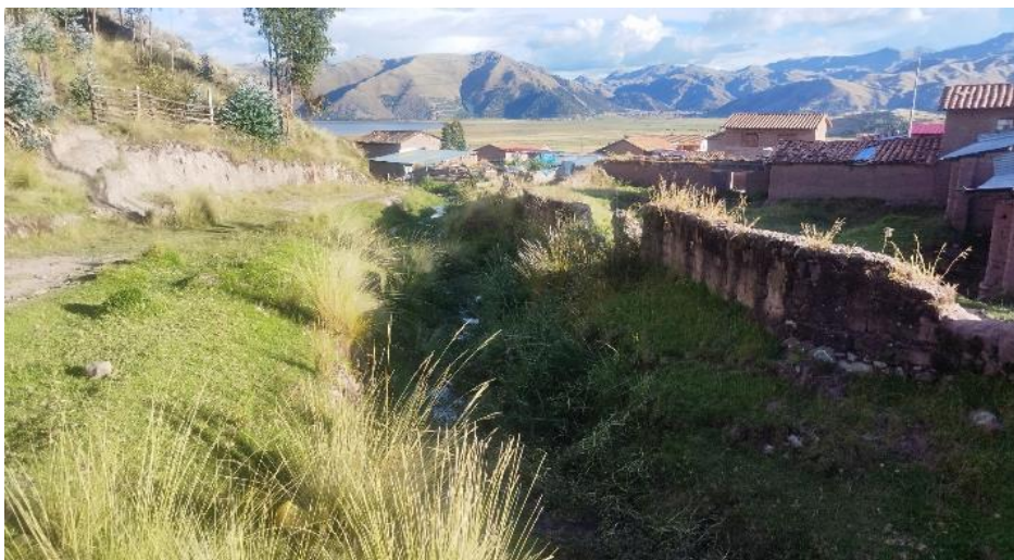
FIGURA N°03: SE APRECIA ASENTADA VIVIENDAS FAMILIARES EN LA MARGEN DERCHA AGUAS ABAJO DE LA QUEBRADA KELLOMAYO Y ASI MISMO EL CAUCE SE ENCUENTRA COLMATADO Y CAUCE ESTRANGULADO.
